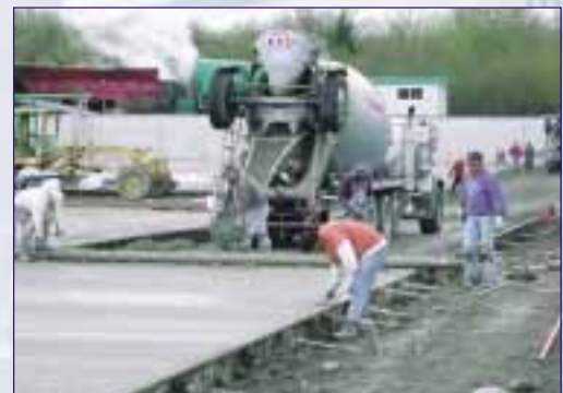
Betonierungsarbeiten beim Aufbau einer UTV-Kompostieranlage in den Vereinigten Staaten
