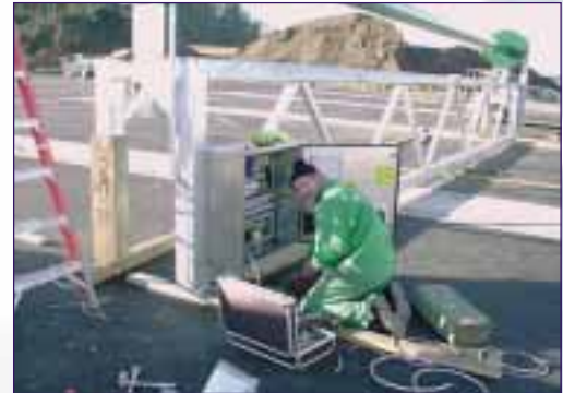
UTV-Kompostieranlage in den USA. Im Bild: Aufbau des gerade angelieferten mobilen Planenwickelgerätes
