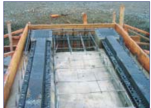
Unter Anleitung: die Installation der Belüftungstechnik
