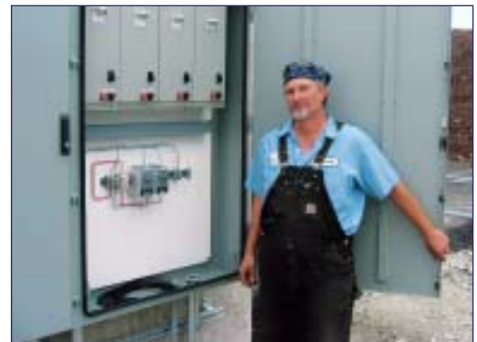
Elektriker Bill Peterson installierte 14,48 km Kabelkanäle und verbrauchte 57,94 km Kabel
